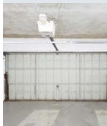
Die maximale Schließkraft nach EN 13241-1 definiert den Wert, ab dem ein Schwingtor mit Antrieb abschalten muss, damit keine Verletzungen oder teure Sachschäden entstehen.
