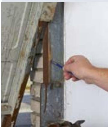
Hier besteht Einklemmgefahr, wenn das Tor bewegt wird. Es fehlen schützende Kunststoffleisten an der Zarge.
