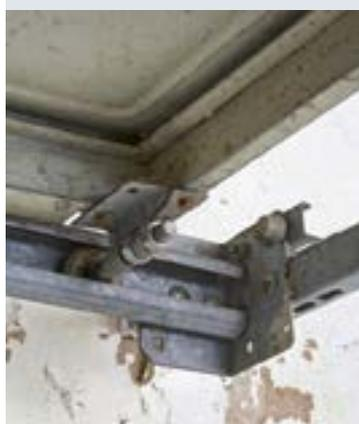
Zum sicheren Stillstand nach dem Öffnen und als Absturz-sicherung sollte die Führungsschiene eine Mulde zur sicheren Aufnahme der Laufrollen aufweisen. Das ist hier nicht der Fall.
