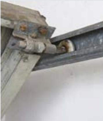
Hier besteht keine Gefahr für Personen und Fahrzeuge. Die Laufschiene ist sicher genug konstruiert, sodass die Laufrollen nicht entgleisen können und das Tor gegen Abstürzen geschützt ist.
